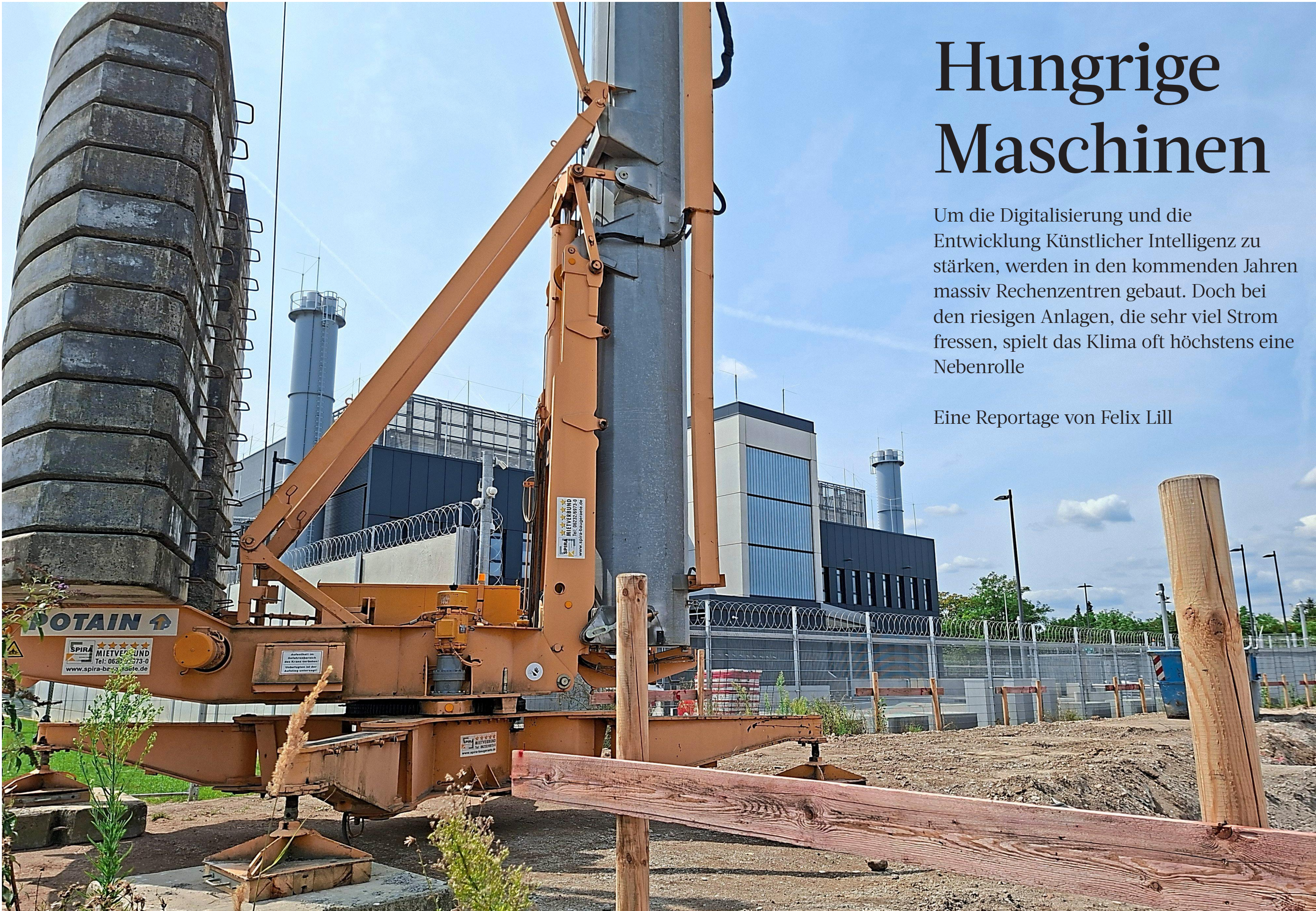
Vor dem Rechenzentrum in Hattersheim entsteht ein Wohnkomplex, der durch die Abwärme beheizt werden soll.
